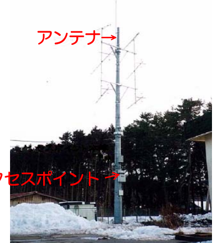
旧共聴施設のパンザマストに設置した無線LANのアクセスポイントとアンテナ
